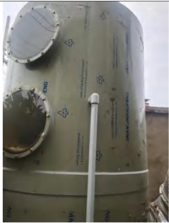
涂胶、预压、热压工序废气处理设施（喷淋+二级活性炭吸附装置）
