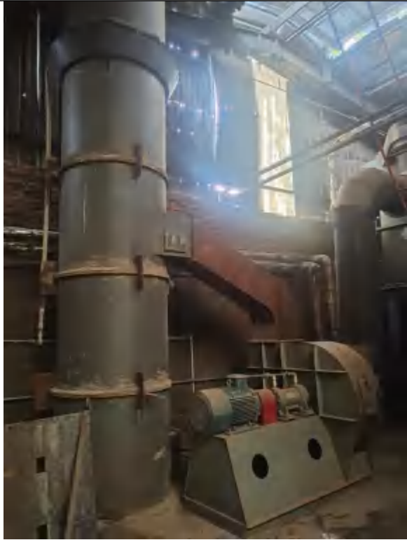
锅炉废气处理设施（多管除尘+布袋除尘+水膜除尘）
