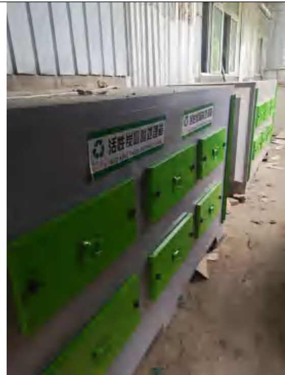
涂胶、预压、热压工序废气处理设施（喷淋+二级活性炭吸附装置）
