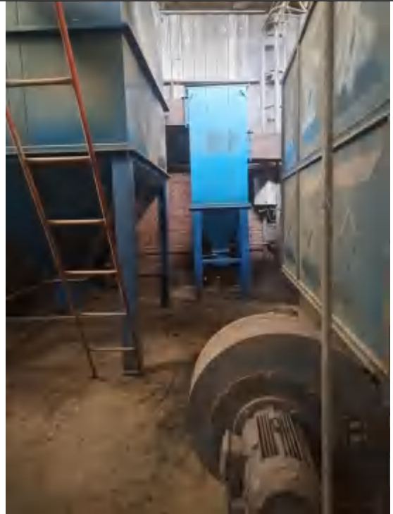
锅炉废气处理设施（多管除尘+布袋除尘+水膜除尘）
